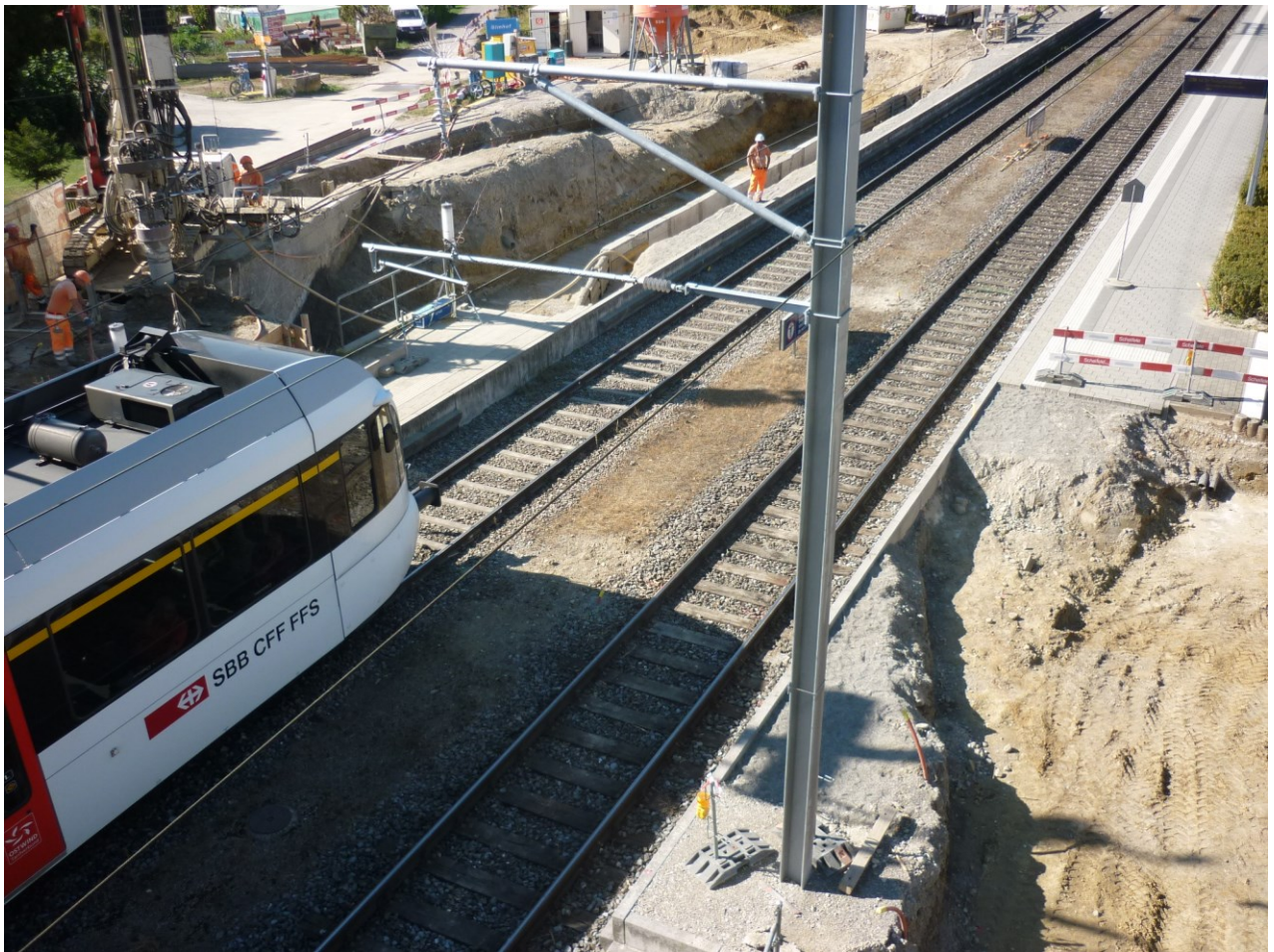
Wo heute eine grosse Baustelle ist wird im Sommer 2017 der neu gestaltete Bahnhof mit hindernisfreien Zugängen zu Bahn und Bus eingeweiht (Foto: Zentralverwaltung)
