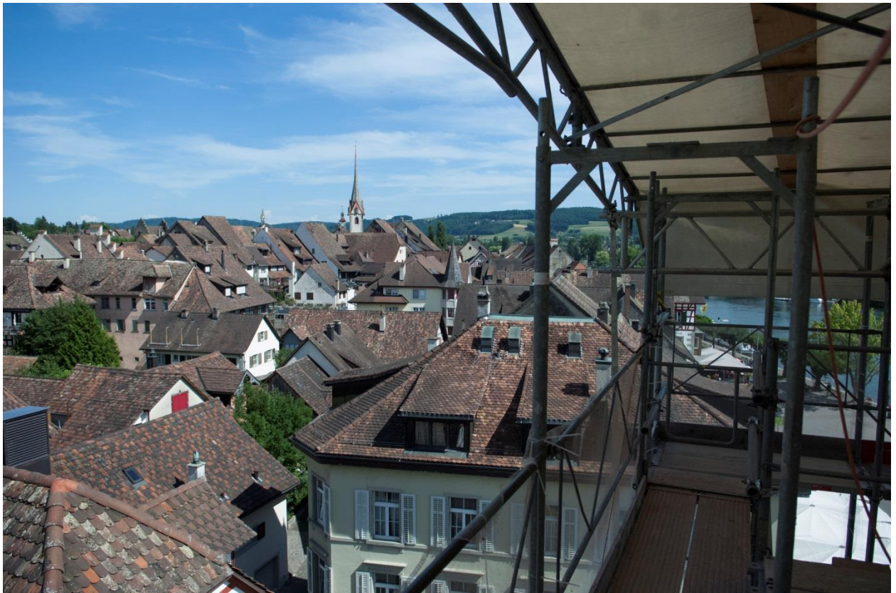
Blick vom eingerüsteten Hexenturm über die Dächer der Altstadt. Der Turm wurde 2017 vom Efeu befreit und saniert (Bild: Jean-Marc Rossi).
