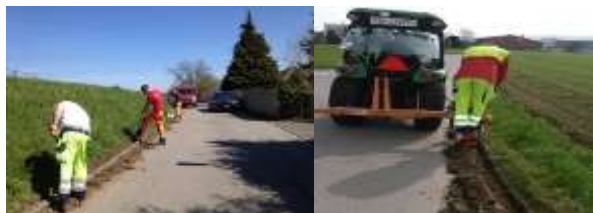
Instandstellung Zwinglistrasse und Degerfelderstrasse
