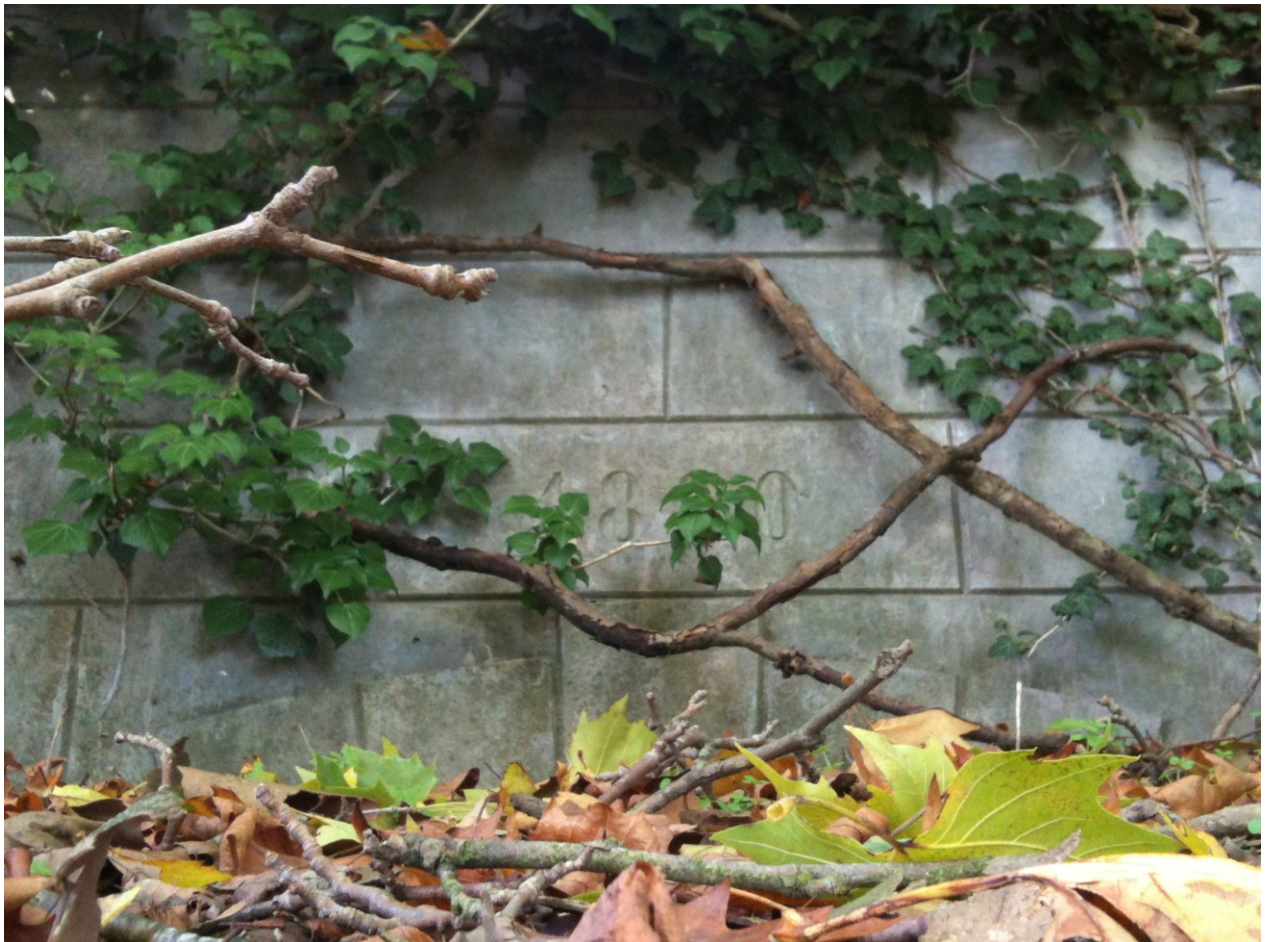
Das über 100 Jahre alte Reservoir Erle entspricht nicht mehr den lebensmittelrechtlichen Vorgaben. Es wird 2014 neu gebaut und erweitert (Bild: Bauverwaltung).
