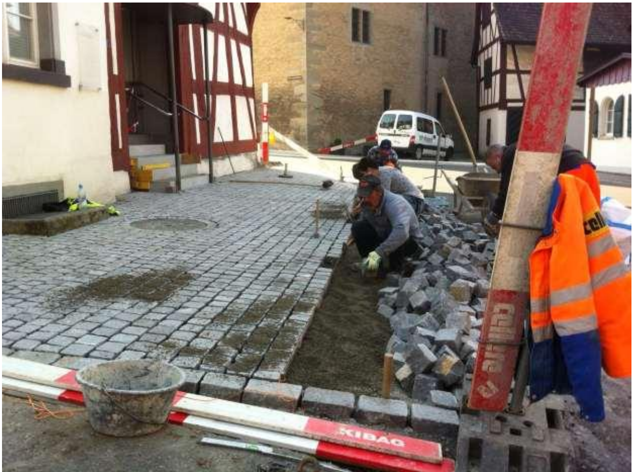
Am 3. März 2013 beschlossen die Stimmberechtigten an der Urne die Sanierung des Chirchhofplatzes. Letzte Arbeiten werden im Frühjahr 2014 ausgeführt. (Bild: Bauverwaltung)
