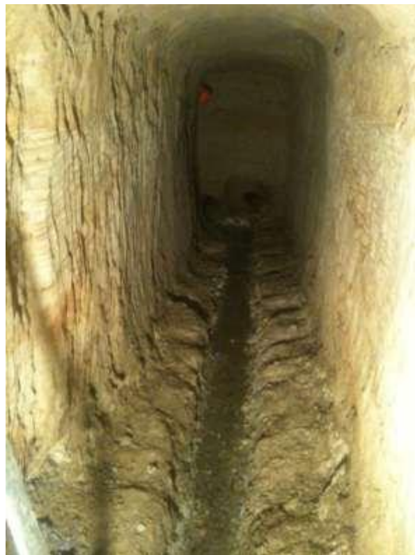
Abbildung: Stollen Quelle Himmelrich, Öhningen
