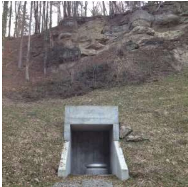
Eingangsbauwerk Quelle Himmelrich, Öhningen
