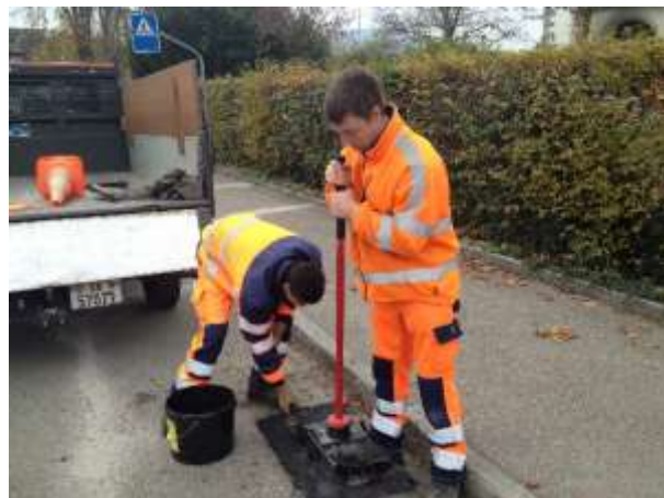
Belageinbau um Strassenrost
