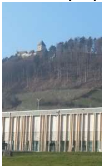
Ein Blick auf die HOGA-Halle, gebaut mit Holz aus dem Steinerwald, und auf den frisch ausgeführten Sicherheitsschlag an der Klingenthalde.
