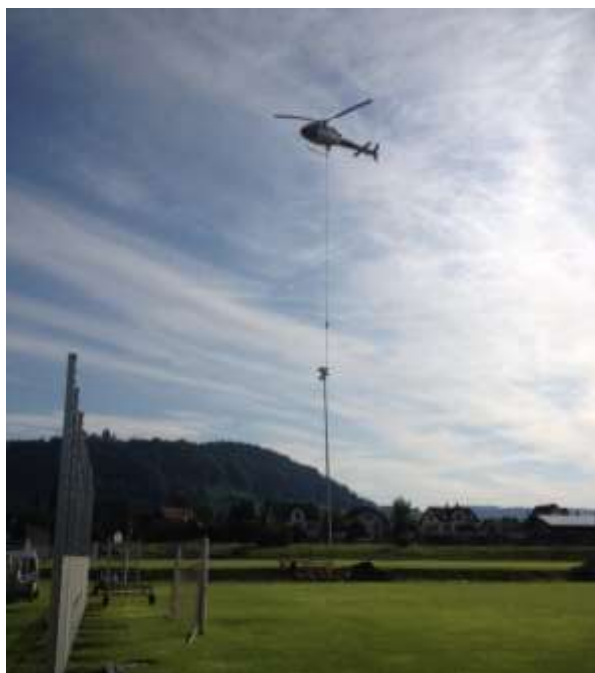
Versetzen der Flutlichtmasten beim Fussballplatz mit Transporthelikoptern
