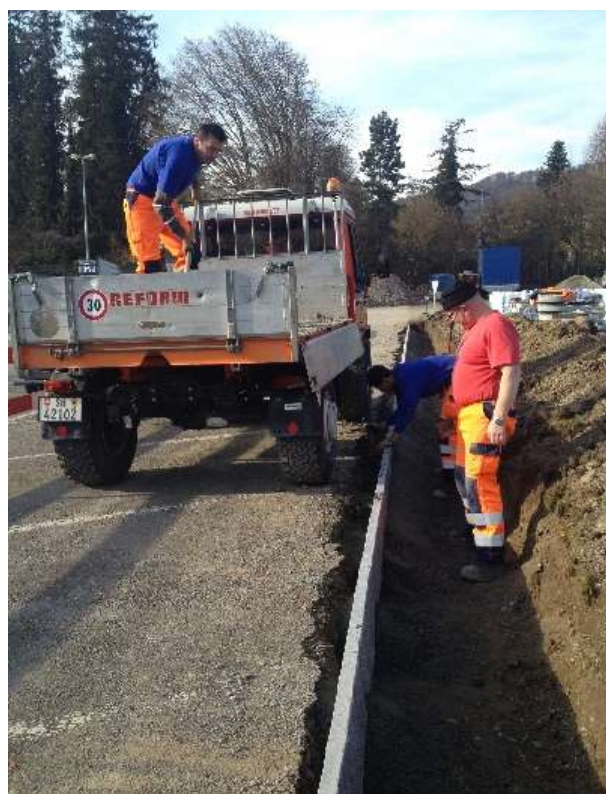
Granitstellriemen setzen
