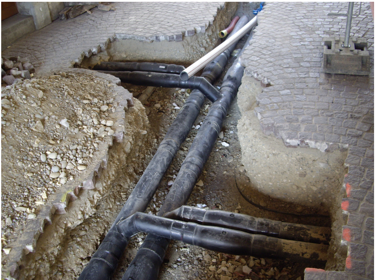
Mit der Netzerweiterung Öhningerstrasse bis zur Harfenkreuzung konnten im Jahr 2009 weitere Liegenschaften an den Wärmeverbund angeschlossen werden.
